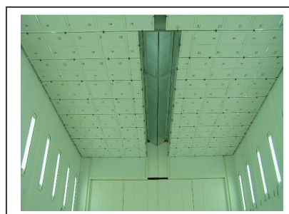
Spalte med automatisk lem i tag for kranindføring
