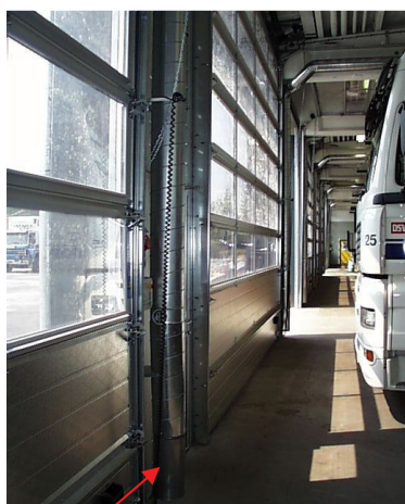
Rumudsugning placeret 100 mm over gulv
