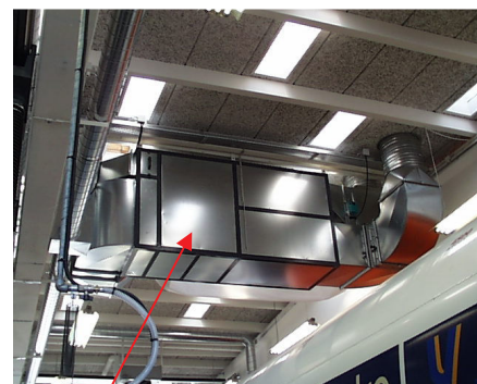
Ventilationsaggregat med krydsvarmeveksler
